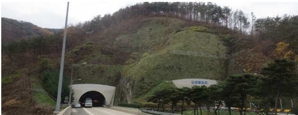
(3구간 중점부 절토사면 정면 전경)
