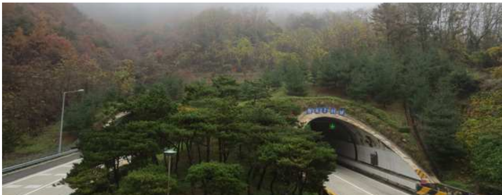
(1구간 시점부 절토사면 정면 전경)
